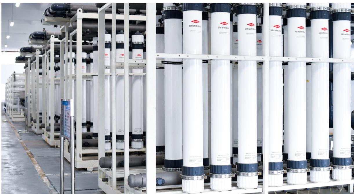
图：水富云天化废水资源化利用减排装置（膜处理）
